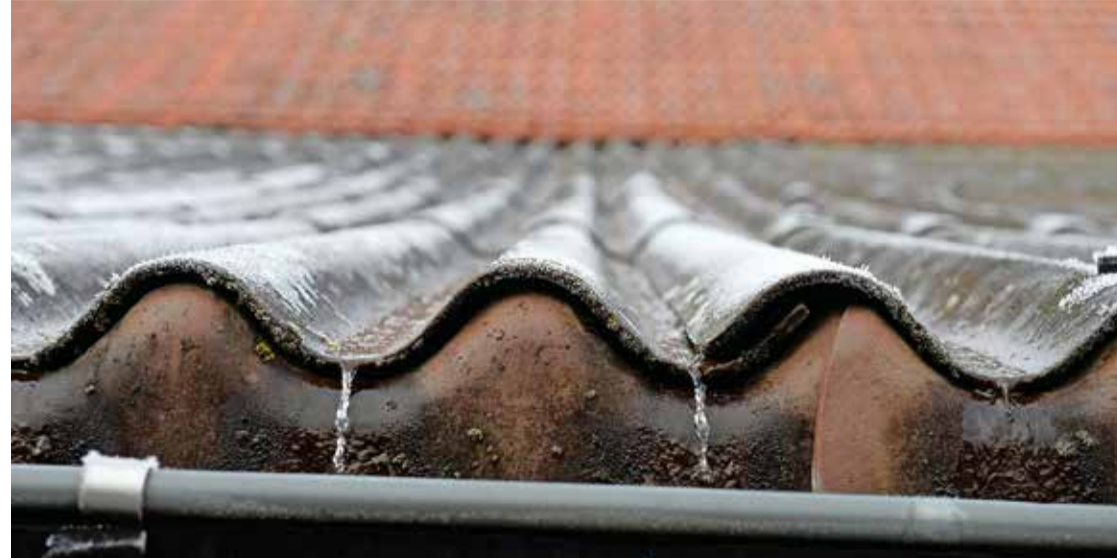
Ein Solarsystem auch für denkmalgeschützte Dächer: Wasser, das frei über Ziegel fliesst. BILD SELWYN HOFFMANN
