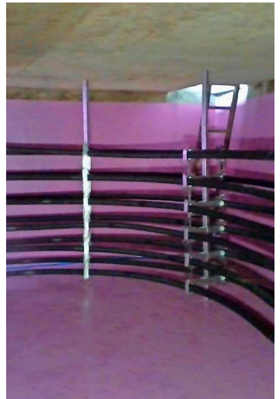
Das zum Eisspeicher umgewandelte Gülleloch, bevor es mit Wasser gefüllt wurde. BILD ZVG
