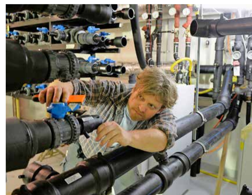
Hydrauliker Jürg Weingart installiert Röhren am Hydrobus. BILD SELWYN HOFFMANN
